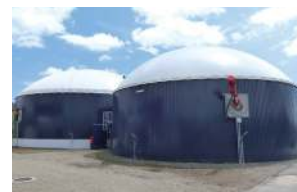
阿寒バイオガス発電所(北海道)
