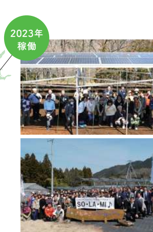
2023年 稼働 さがみこファーム ソーラーシェアリング発電所 「SO・LA・MI」
