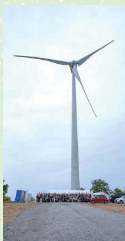
2025年3月に稼働した風車「千颯」
