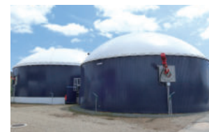
阿寒バイオガス発電所(北海道)
